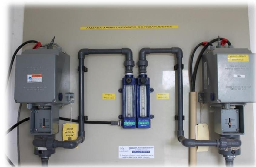
Imagen 7 - Válvulas para cloración en Rompuquetes
