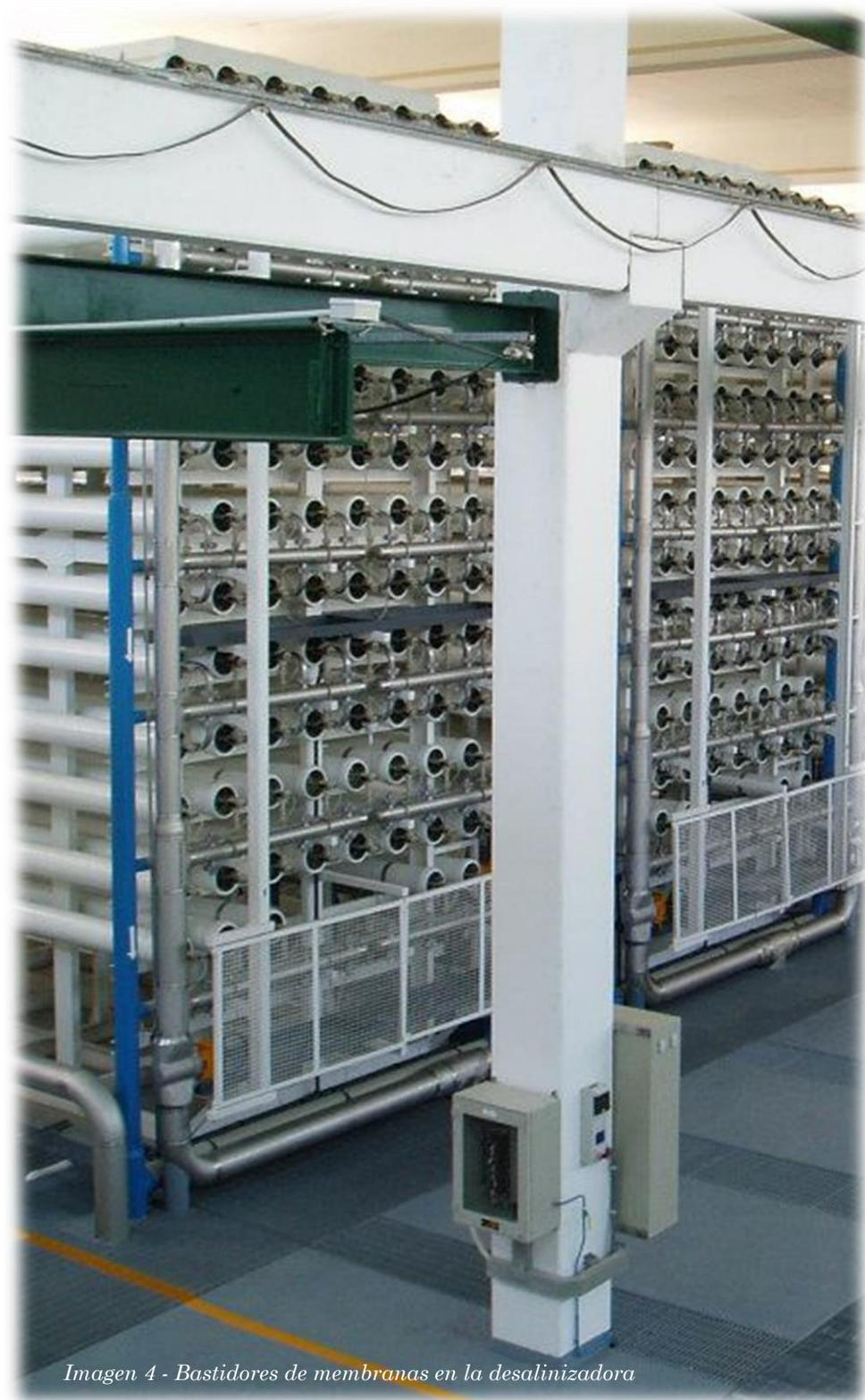
Imagen 4 - Bastidores de membranas en la desalinizadora
